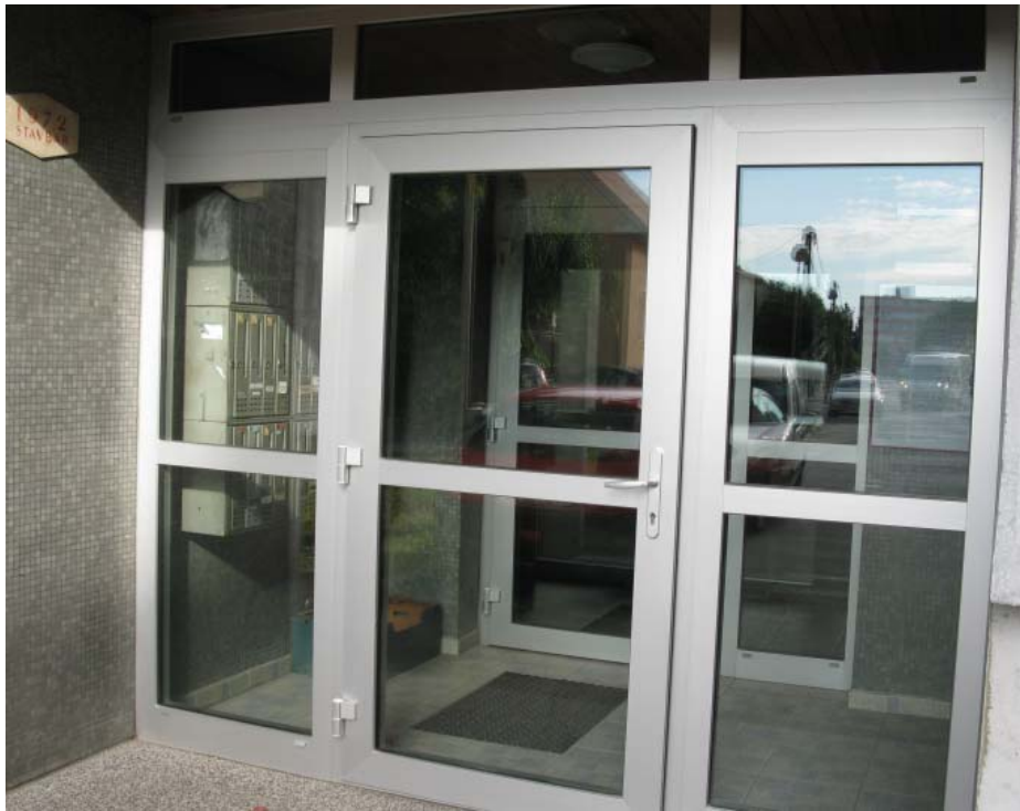
Slika 6: Izvedba vhodnih vrat s vetrolovom, aluminijastimi okviri in dvojno zasteklitvijo.
