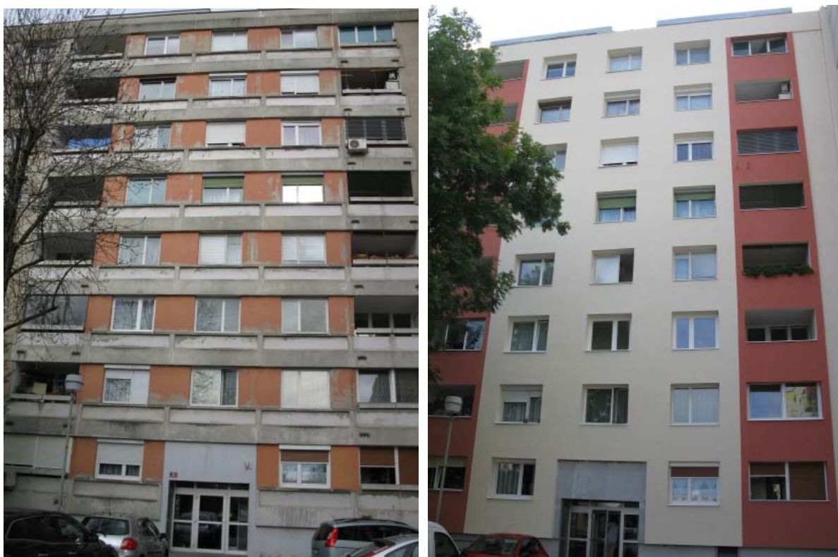
Slika 1: Pajkova ulica 22, pred sanacijo fasade (levo) in po njej (desno).
