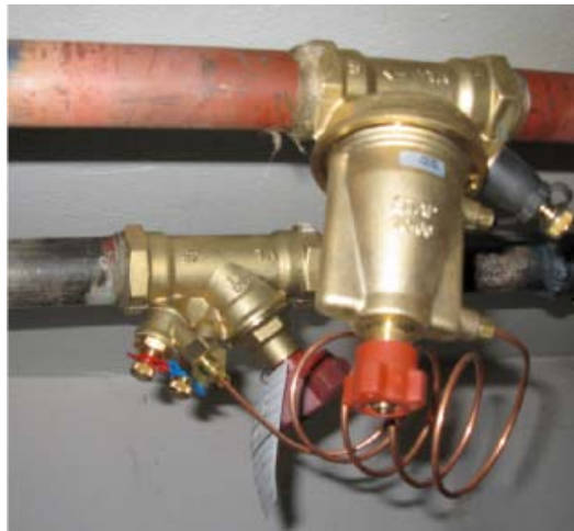
Slika 9: Regulator tlaka (STAP) in regulator pretoka (STAD) povezana s kapilarno cevjo.
