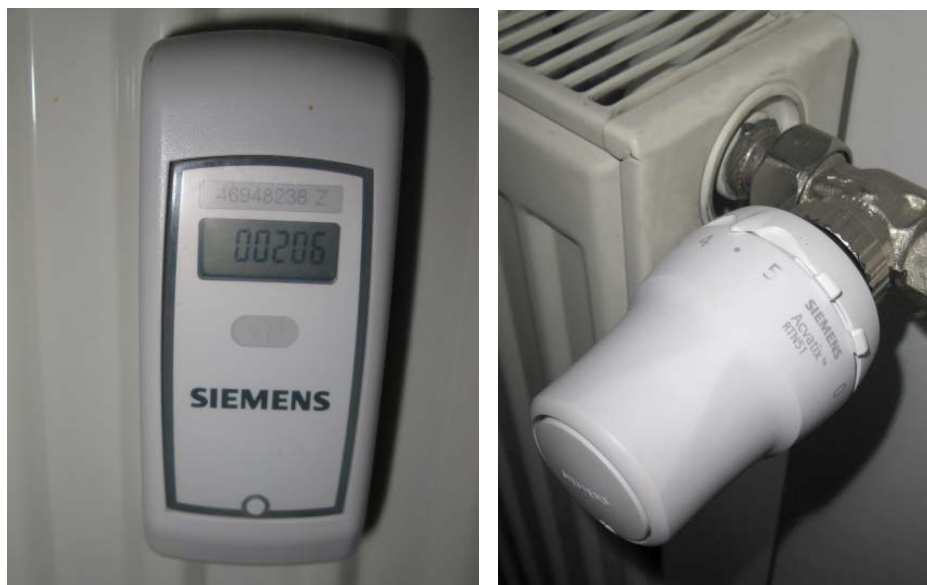
Slika 7: Delilnik stroškov porabljene toplote (levo), termoregulacijski ventil (desno).
