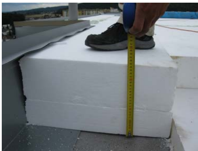
Slika 5: Izolacija zgornje etaže strehe s EPS debeline 25cm.
