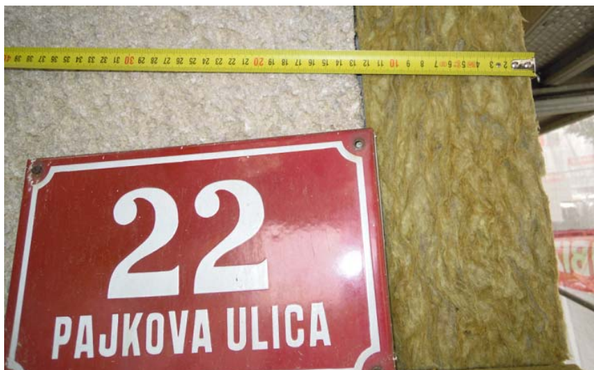
Slika 4: Izolacija fasade s KNAUF z izolacijskimi ploščami PTP-035 debeline 12cm.
